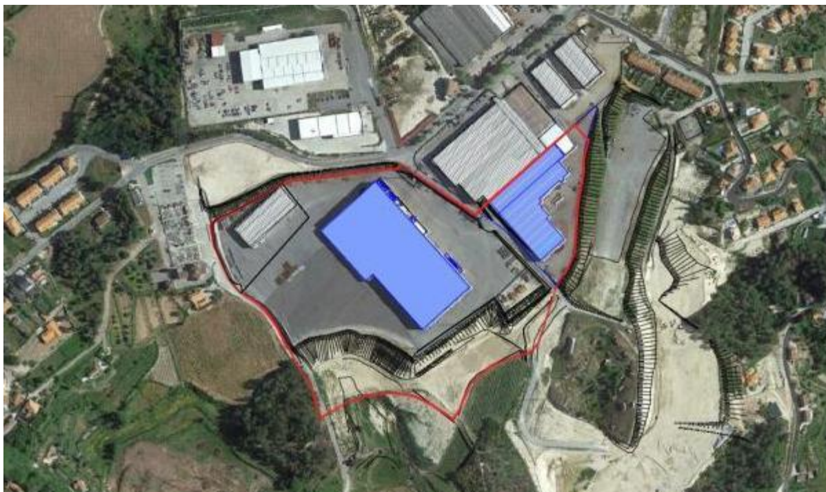
Figura 3: Localização da “METALOCARDOSO” sobre fotografia aérea (Fonte: EIA – Julho de 2016).
